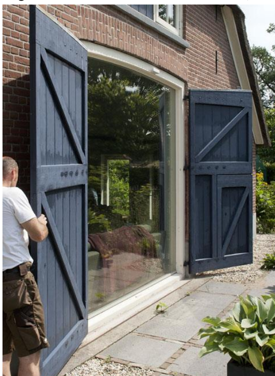
Beeld van open gat door plaatsing enkele glasplaat
