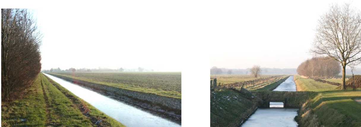
Afb. Uitgevoerde werkzaamheden in het kader van de ruilverkaveling
