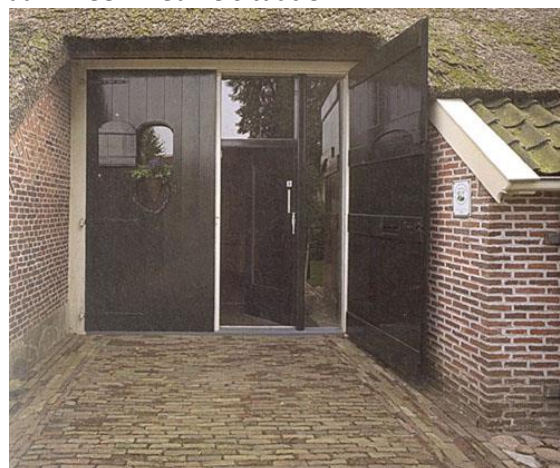
Eén baanderdeur vast, één ingevuld als nieuwe entree, waarbij de middenstijl duidelijk aanwezig is.
